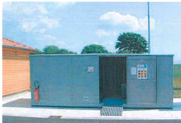
Photo n°5 : Exemple du type d'armoire DDS qui sera mise en place.
